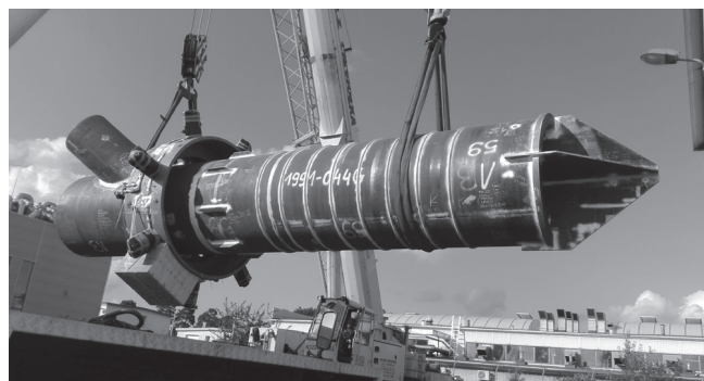
Rys. 1. Gotowa kolumna Fig. 1. The PIN is ready
