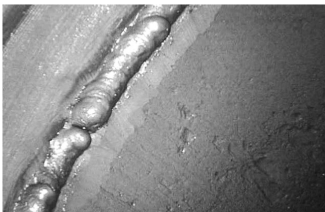
Rys. 1. Badania wizualne za pomocą wideoendoskopu. Fragment spoiny obwodowej. Punktowy brak przetopu [1]
