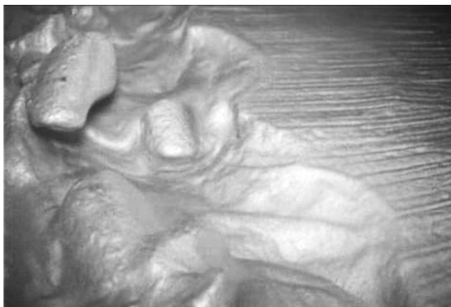
Rys. 2. Badania wizualne za pomocą wideoendoskopu. Fragment spoiny obwodowej. Wklęsłość grani spoiny i podtopienia [1]
