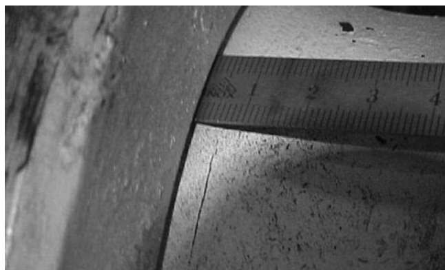
Rys. 1. Przykład ilustracji graficznej z katalogu EVIC oceny wizualnej pęknięcia w kategorii uszkodzeń mechanicznych na osiach niemalowanych [3]
