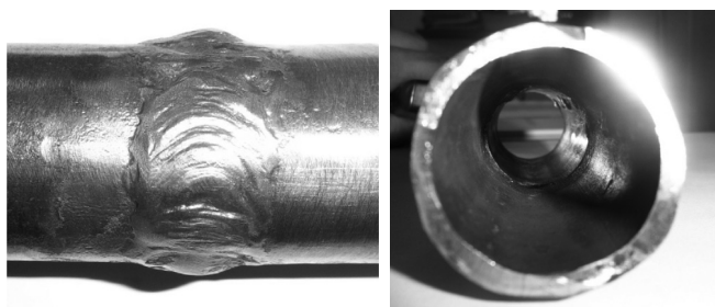
Rys. 3. Lico i grań spoiny rury o średnicy 33,7 mm i grubości ścianki 2,9 mm
