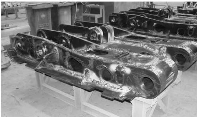
Rys. 13. Konstrukcje osłony po oszlifowaniu wykańczającym, przygotowane do malowania Fig. 13. Shield construction after final grinding, ready for painting
