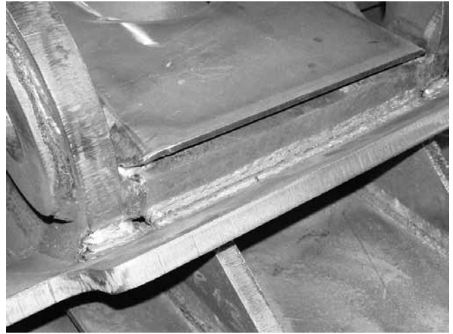
Rys. 9. Przygotowanie (ukosowanie) krawędzi blach pod spoiny czółowe
