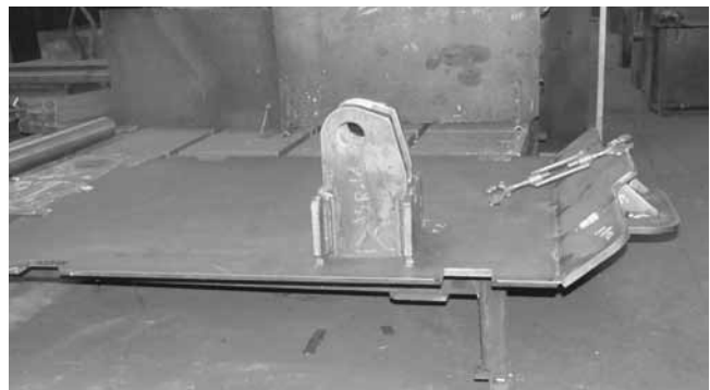
Rys. 5. I etap składania – stosowanie ściągów do ustawiania i szczenia Fig. 5. Composing of first stage – using stays for positioning and tacking
