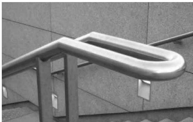
Rys. 1. Poręcz wykonana ze stali nierdzewnej Fig. 1. The austenitic steel balustrade
