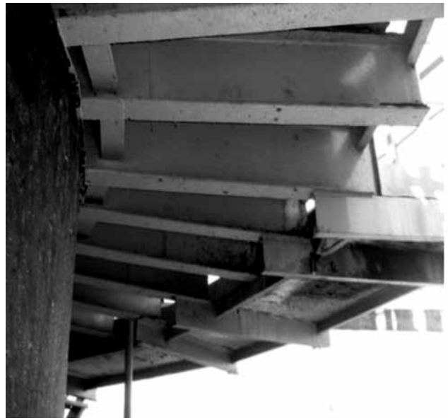
Rys. 5. Zewnętrzny krawędziowy odcinek rusztu podzbiornikowego Fig. 5. Outer edge section of the grate under tank
