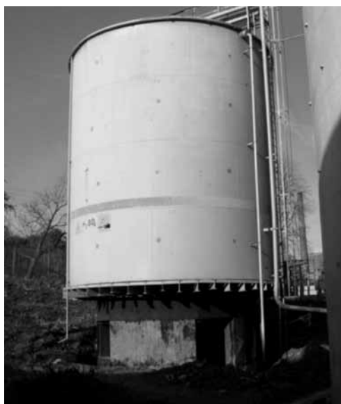
Rys. 1. Widok ogólny zbiornika Fig. 1. General view of the tank
