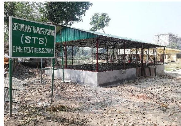
(d) Secondary transfer station (STS)
