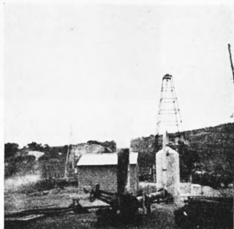
Fig. 19 - Particolare del pozzo della fig. 18. Erogazione del vapore dopo il separator. Portata totale: 30-50 ton/h (acqua+vapore); temperatura al separa- tore: 105° C; rapporto acqua/vapore: 4-5; profondità della zona in erogazio- ne: variabile fra m 590 e m 900; tem- perature delle zone provate, prima e dopo le prove, a pozzo pieno di acqua: da 195°C a 210°C. Data: Maggio 1953.
