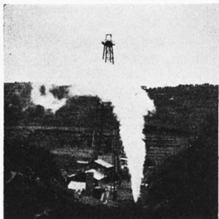
Fig. 21 - Particolare del pozzo della fig. 20. Erogazione del vapore dopo il separatore. Portata totale: ca. 10 ton/h (acqua + vapore); temperature al separatore: 105°C, rapporto acqua/vapore: da 1,65 a 1,24; profondità della zona in erogazione: da 1440 m a 1728 m; temperatura della zona provata, prima e dopo la prova, col pozzo pieno di acqua: da 225°C a oltre 295°C. Data: 1953
