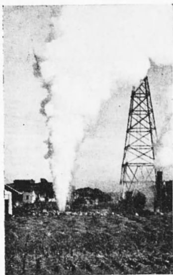
Fig. 29 - Cetara Alta (Isola d'Ischia, Napoli). Pozzo in fase di erogazione di acqua e vapore nella libera atmosfera. Portata: circa 100 ton/h (acqua + vapore) a bocca libera
