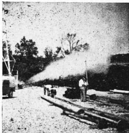
Fig. 12 - Località: Travale (Regione dei Soffioni boraciferi toscani); portata totale: ca. 40 ton/h (vapore acqueo ricco di gas); temperatura all'uscita: 108°C (1 Ata); rapporto gas/vapore: 42 l/kg; profondità della zona in erogazione: ca. 70 m. Notare l'aspetto e la forma del getto. Data: 1953
