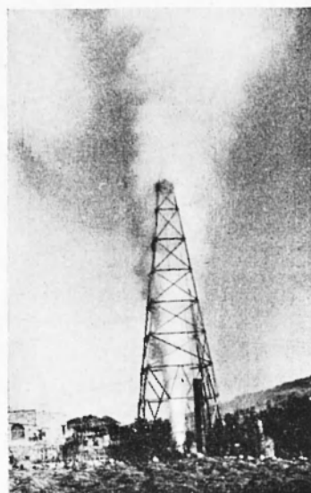
Fig. 30 - Particolare del pozzo della fig. 29. Portata totale dopo il separatore e strozzatura: ca. 50 ton/h (acqua + vapore); temperatura al separatore: 138°C; rapporto acqua/vapore: 6,9; profondità della zona in erogazione: m 240; temperatura della zona provata, prima e dopo la prova, a pozzo pieno d'acqua: 176°C. Data: 1953
