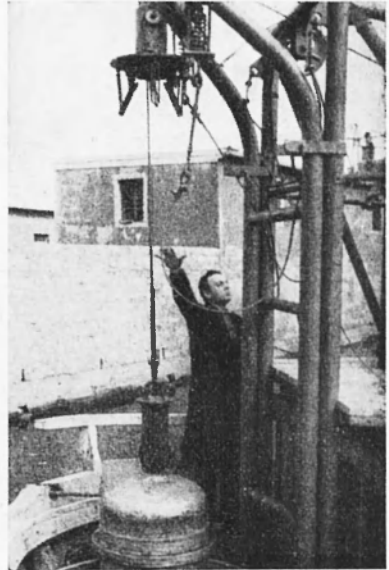
Fig. 8 - La batiferà calata sul ponte.
