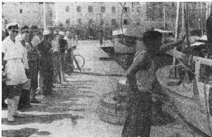
Fig. 16 - La base a terra di Grado.
