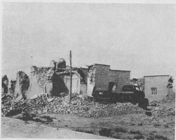
Maisons administratives de Miam-Dachte.
