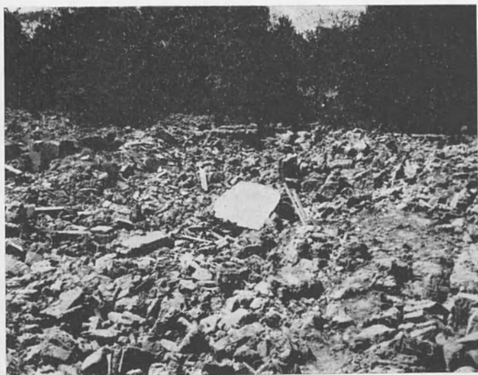
Dacth-é-Baïaz après le tremblement de terre du 31 Août, 1968.
