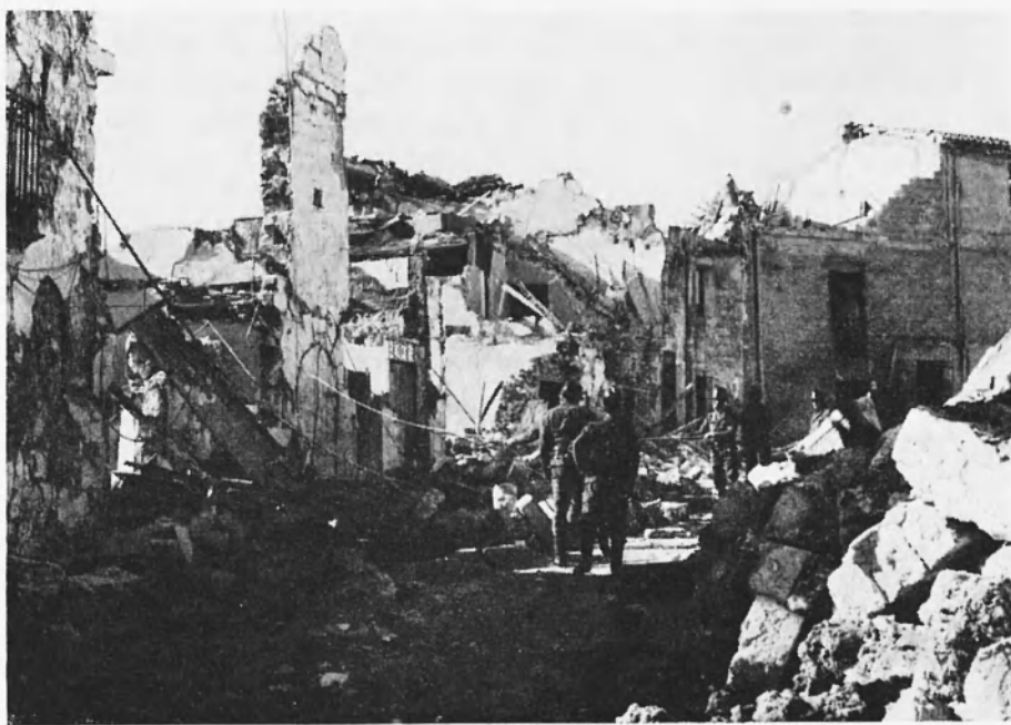
Foto 7. - Gibellina - Vigili del fuoco intenti a demolire murature pericolanti.
