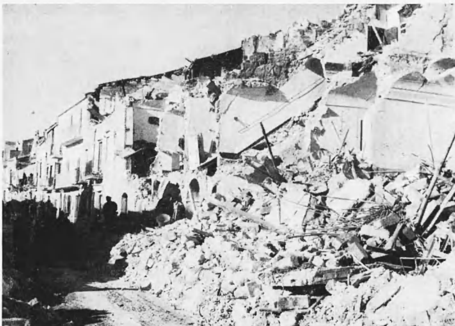
Foto 4 - Gibellina - Effetti del terremoto su edifici in muratura.
