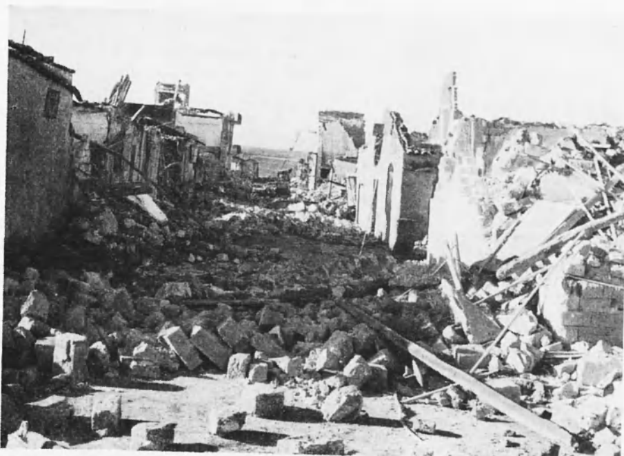
Foto 9. - Montevago - Una strada del paese fiancheggiata da case distrutte.
