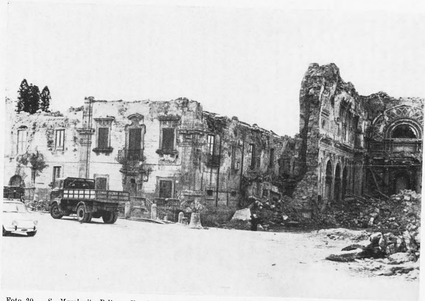
Foto 20. - S. Margherita Belice - Il palazzo Filangieri e la Chiesa Madre dopo la forte replica del 25 gennaio 1968.
