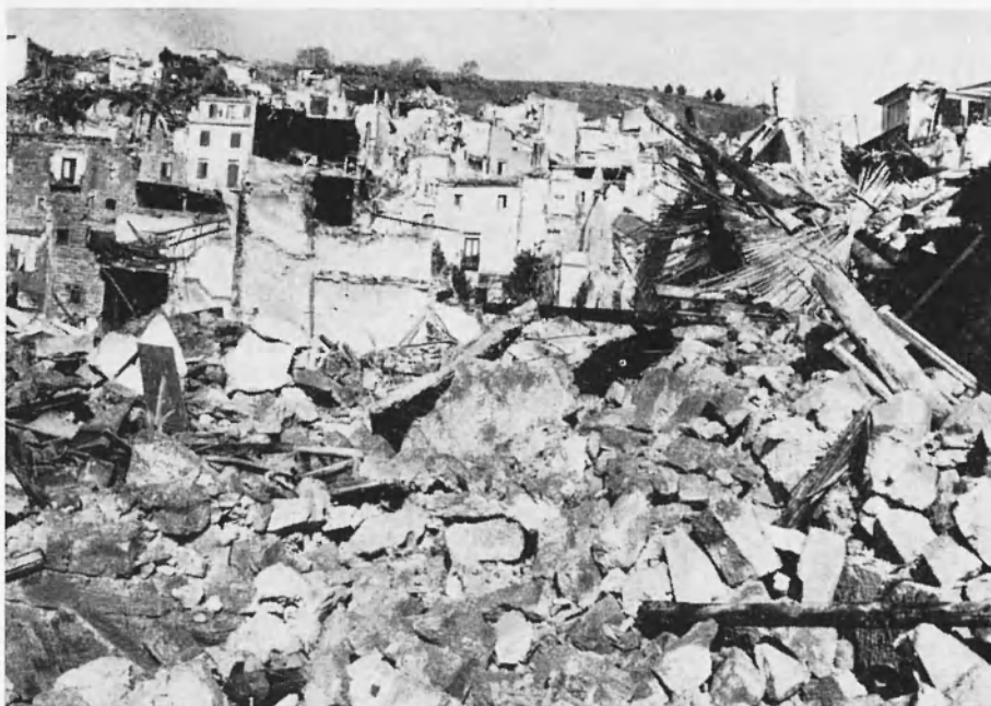
Foto 5. - Gibellina - Case in muratura ridotte ad informi ammassi di travi, detriti e blocchi di tufo.
