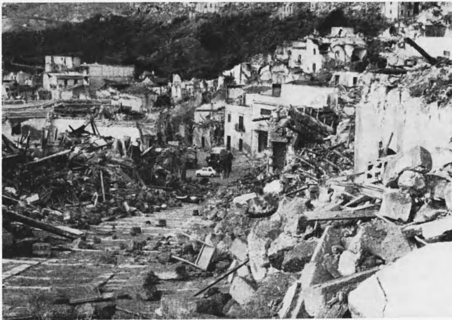
Foto 3. - Un'altra strada di Gibellina dopo il terremoto.
