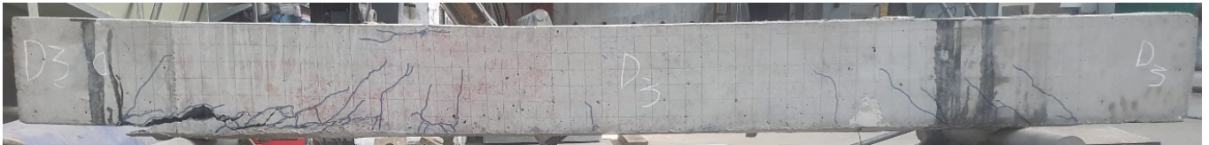
(d) Rupture type of D3: Slip failure at the left end.
